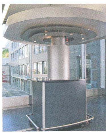
aeropole-Systeme wie der airTower filtern 99,9995 % der Schadstoffe.
